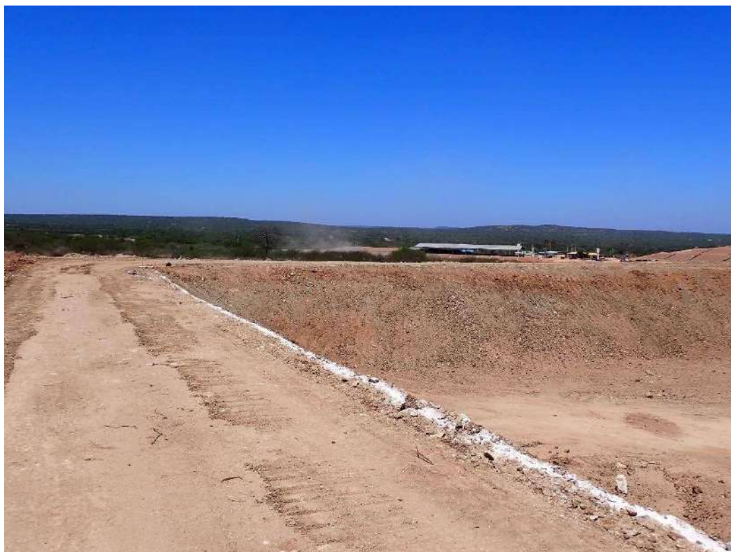
Foto 7 – Terraplenagem da quinta lagoa de contenção de chorume que irá substituir as lagoas 3 e 4.
