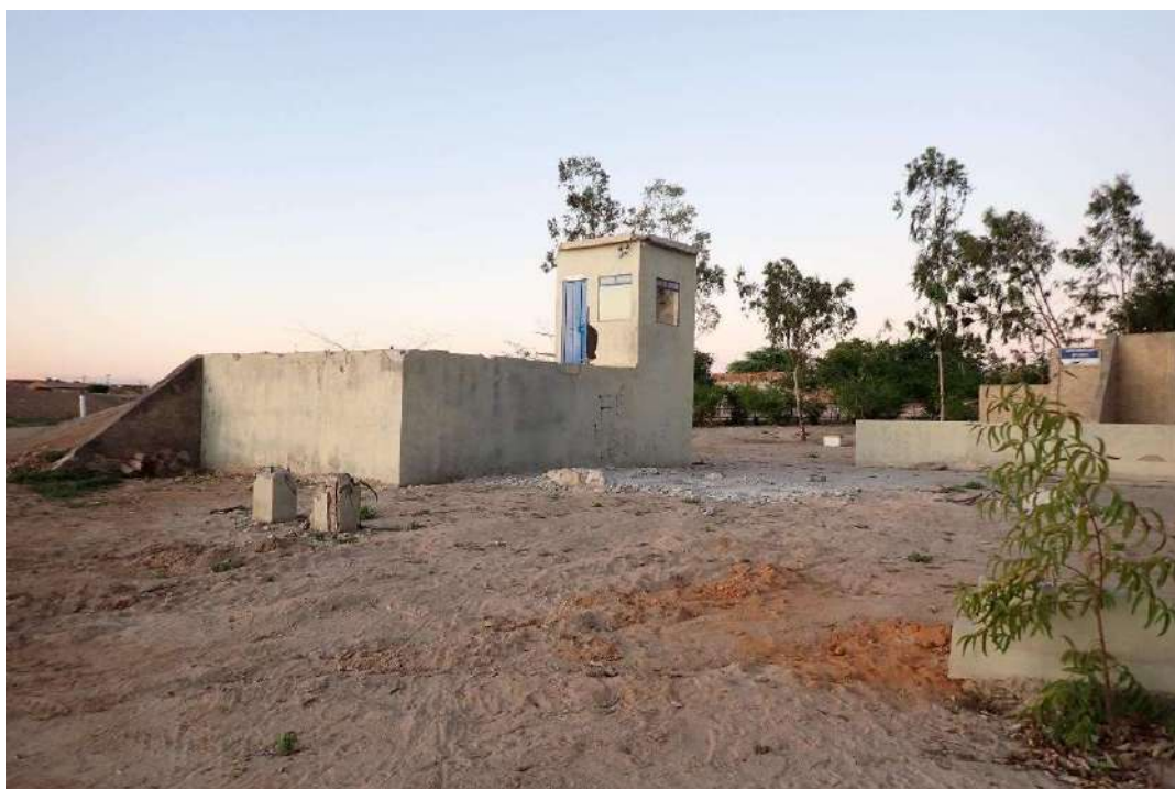
Foto 14 – Desativação da usina de beneficiamento de entulho para transferência à Nova CTR.
