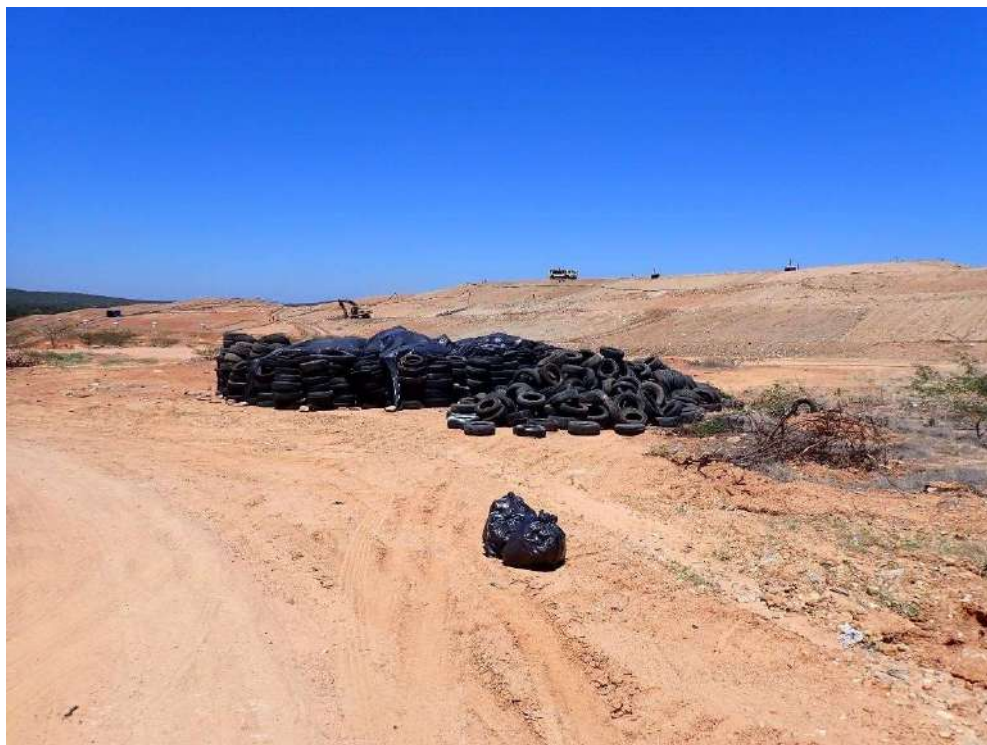
Foto 11 – Resgate de pneus da frente de serviço para encaminhamento a processos de logística reversa.
