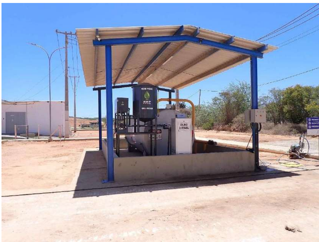
Foto 9 – Implantação de filtro prensa no sistema de abastecimento de óleo diesel.
