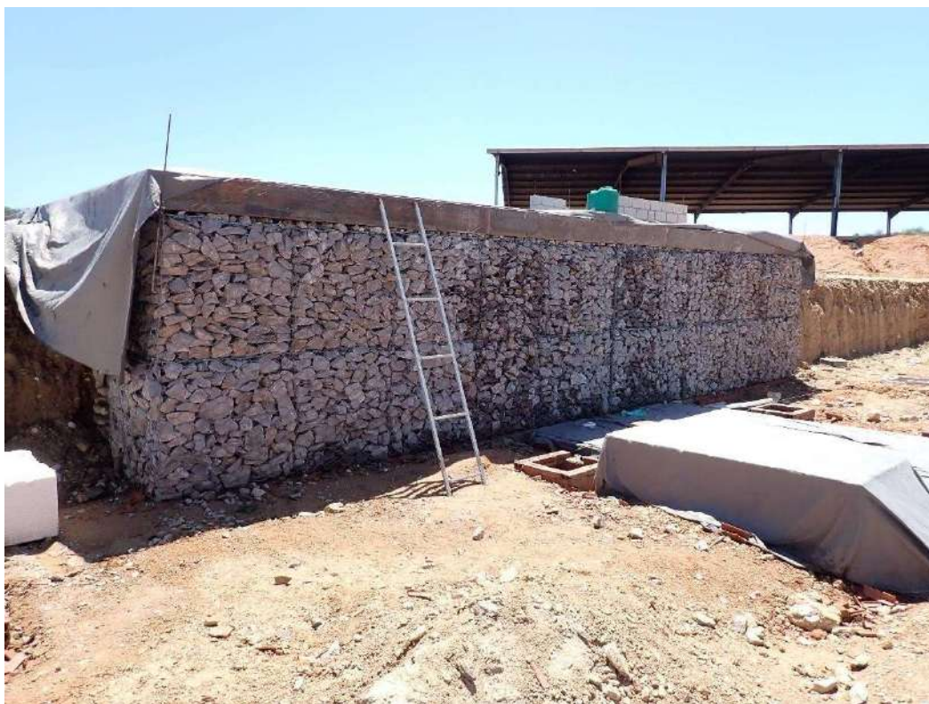
Foto 3 – Obras de adequação da infraestrutura requerida para transferência para a nova CTR da unidade de beneficiamento de entulho.
