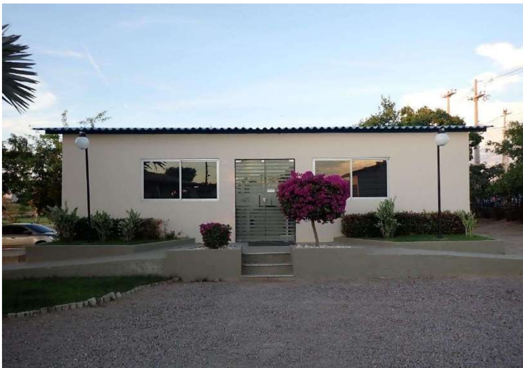
Foto 15 – Manutenção e renovação do paisagismo dos blocos prediais da ARA. Os eucaliptos que ficavam nos fundos e que tinham atingido grande altura oferecendo risco para o prédio, foram suprimidos e substituídos por mudas de espécies nativas.
