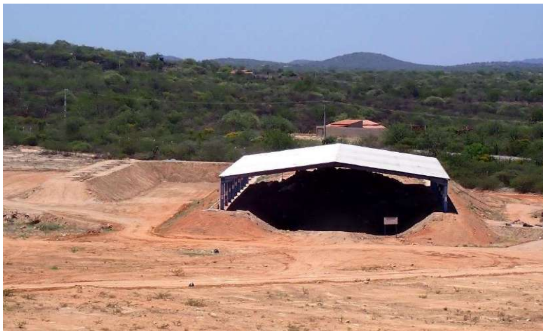
Foto 5 – Terraplenagem do terceiro avanço de célula do aterro para resíduos perigosos Classe I.
