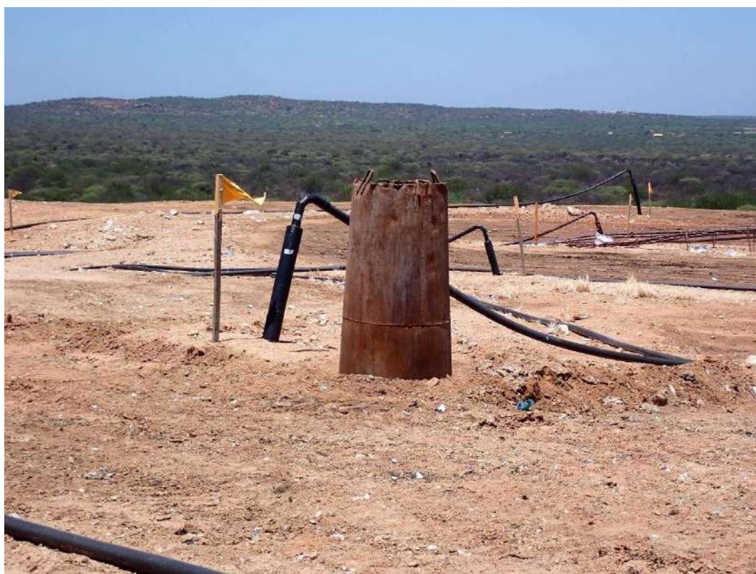
Foto 10 – Implantação de novos poços de gás na célula para reforço da captação.
