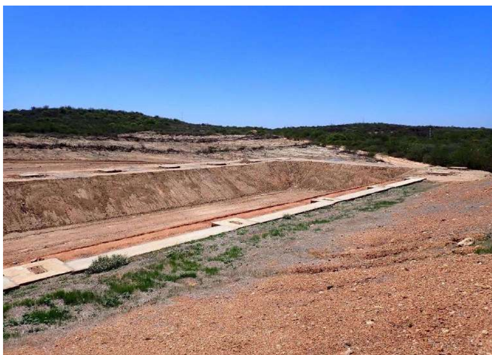
Foto 6 – Terraplenagem da quinta lagoa de contenção de chorume que irá substituir as lagoas 3 e 4
