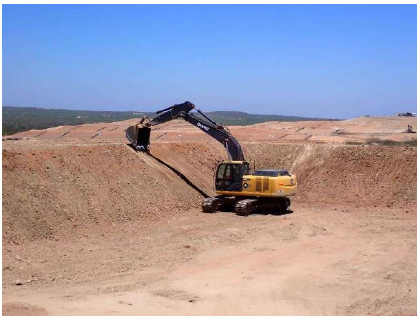
Foto 4 – Terraplenagem do terceiro avanço de célula do aterro para resíduos perigosos Classe I.
