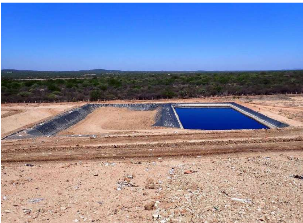
Foto 8 – Lagoas 3 e 4 de contenção de chorume em processo de desativação e adequação como base impermeabilizada de célula.
