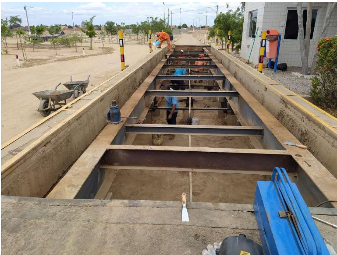
Foto 11 – Manutenção da balança de pesagem.
