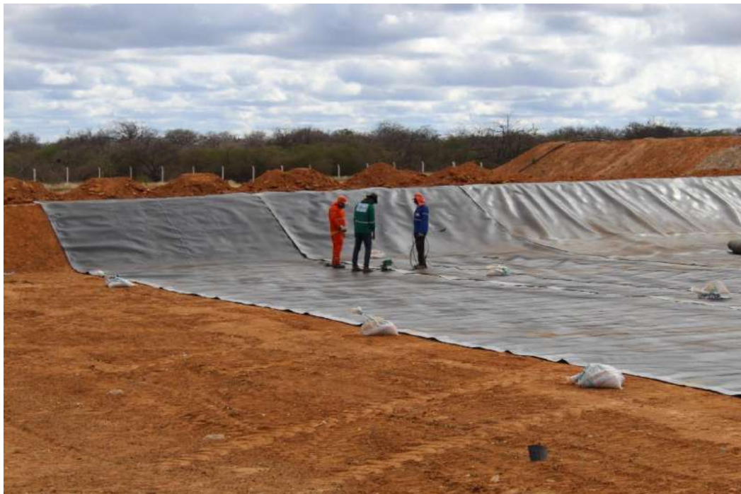
Foto 3 – Aplicação de manda de PEAD de 1,5mm em julho de 2021
